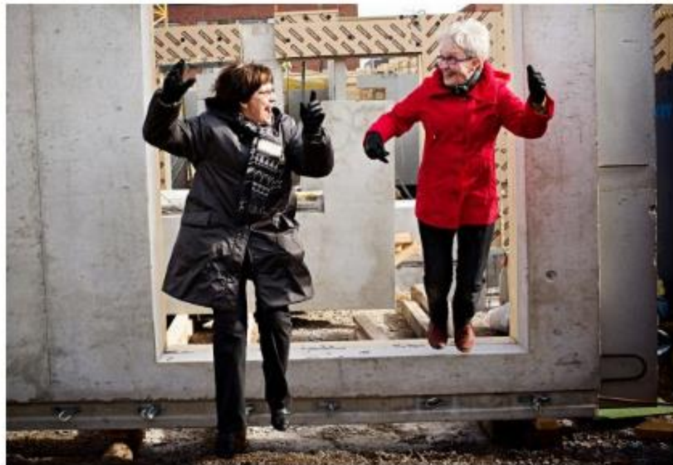
Aktiivisten seniorien puuhanaiset Britta Lungdell ja Terttu Fält irrottelevat yhteisötalon rakennustyömaalla Kalasataman Arielinkadulla. He ovat olleet suunnittelemassa Kotisataman yhteisiä tiloja.
