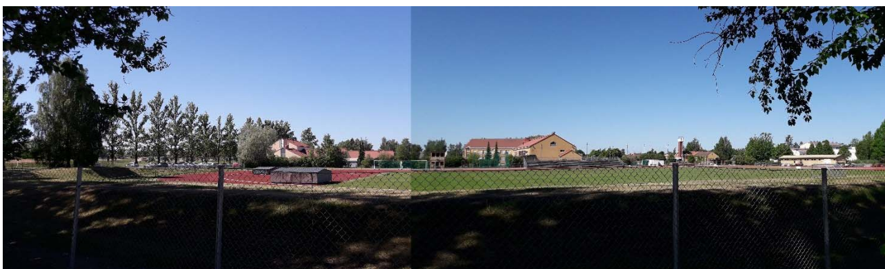
Panoraamanäkymä Mannilantien suunnasta urheilukentän ja koulukorttelin alueelle. Nähtävissä Juholan koulu, vanha kansakoulu / Opistojen talo, huoltorakennusryhmä ja entinen lämpökeskus torneineen sekä oikealla urheilukentän huoltorakennus, jonka taustalla yhtenäiskoulun Urheilukentäntien rakennuksia.
