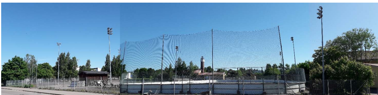
Panoraamanäkymä koulukorttelin pohjoisosaan Kansakoulunkadun suunnasta – tenniskenttien ja kiekkokaukalon alue, taustalla lämpökeskuksen rakennukset.
