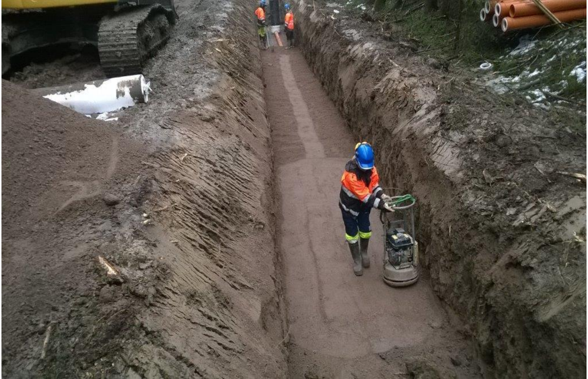
Kuva: Reijo Aronen, Itä - Nummenkylän vesihuollon rakentaminen
