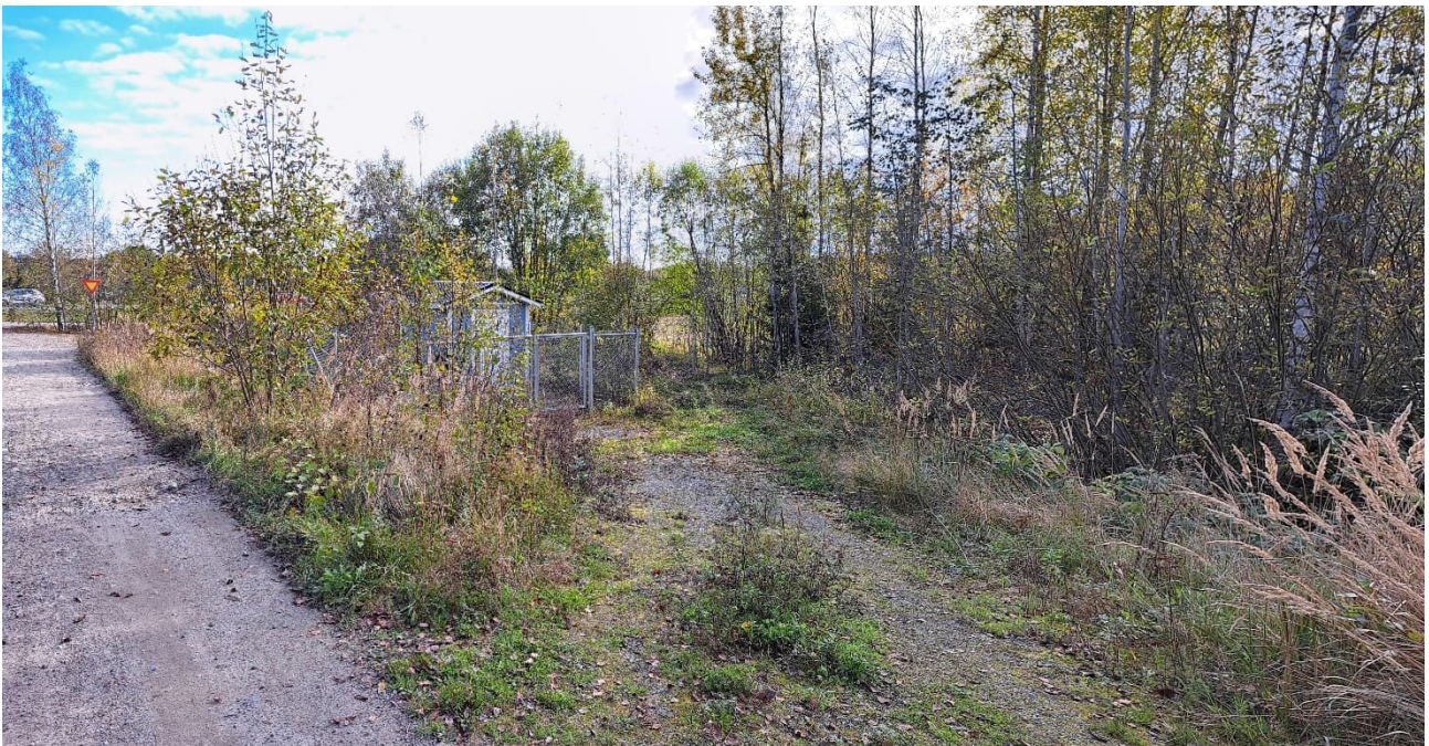
Aidattu jätevesipumppamo Änäsinpolun eteläpuolella.
