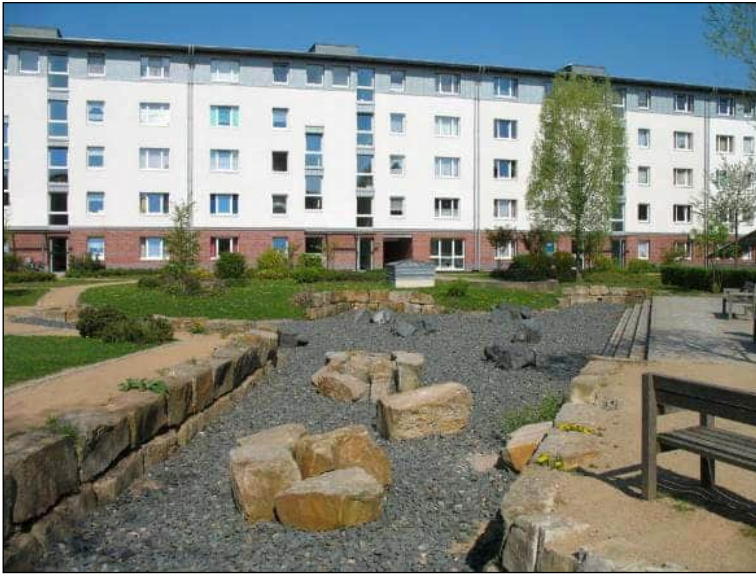
Kuva 20 Kuiva, kivetty viivytyspainanne. 17
