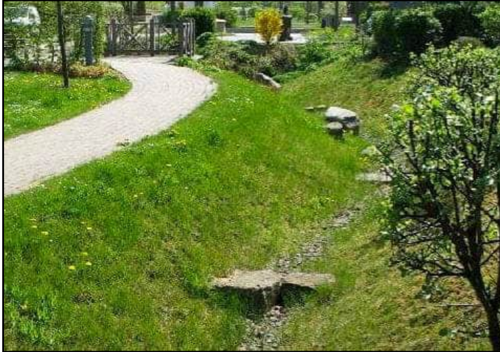
Kuva 28 Esimerkki hulevesien pintajohtamista kadun reuna-aojassa, johon on istutettu kasvilisuutta ja rakennettu pohjapatoja.
