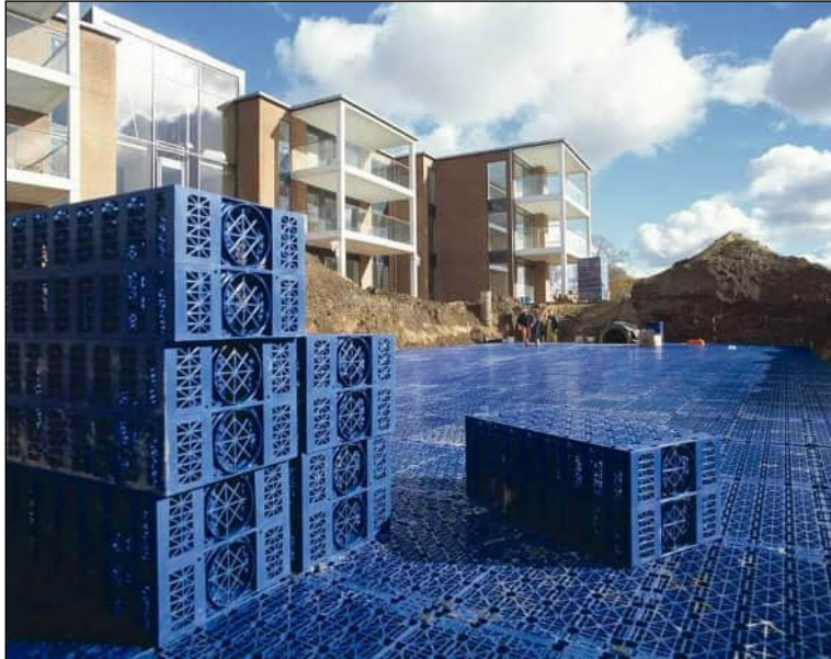
Kuva 22 Muovinen hulevesikasetti. 19
