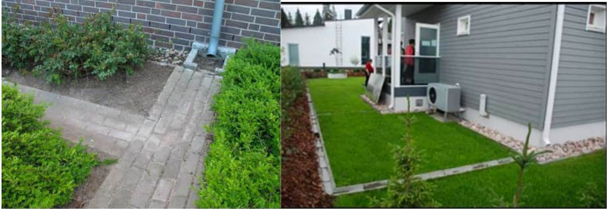
Kuva 23 Esimerkki kattovesien johtamisesta. Esimerkissä hulevedet johdetaan syksytorvista betonista kourua myöden viherkaistaleelle, joka sijaitsee riittävän etäällä rakennuksesta. Vasen kuva on Hannoverista ja oikea kuva Tampereen Vuoreksesta.
