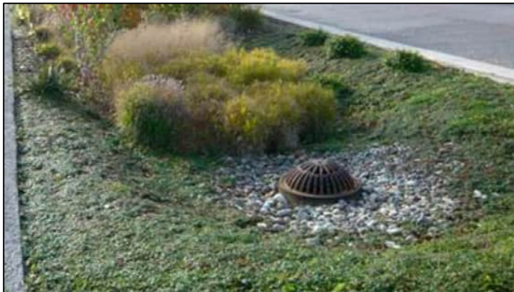
Kuva 29 Esimerkki katualueen viherpainanteesta, jossa on ylivuotojärjestelmä hulevesiviemäriverkkoon (Seattle, USA).
