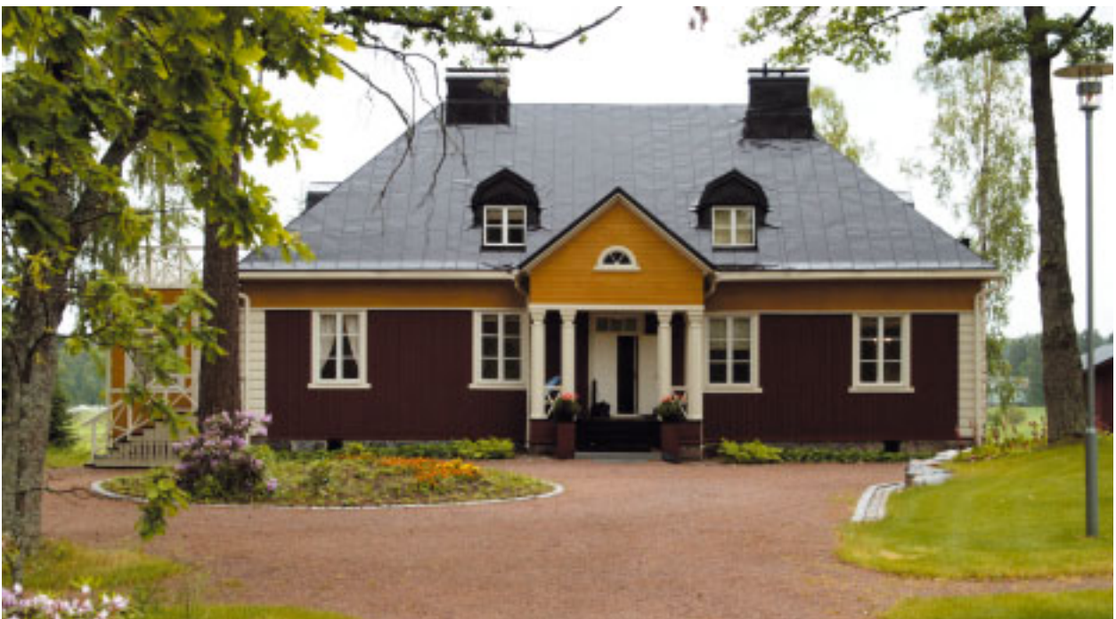
Kumpareen juurella sijaitsevan Yrjö Paloheimon talon edusta on puutarhamainen lampineen ja istutuksineen. Rakennus ja sen pihapiiri on kunnostettu 2000-luvun alussa Sibelius-Akatemian käyttöön.
