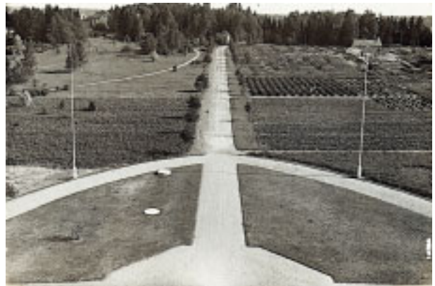
Kotitalousopettajaopiston puutarha on ollut säännöllinen muotopuutarha. Kuvan kaarikäytävät ovat ruohottuneet, mutta perusmuoto on yhä tallella.
