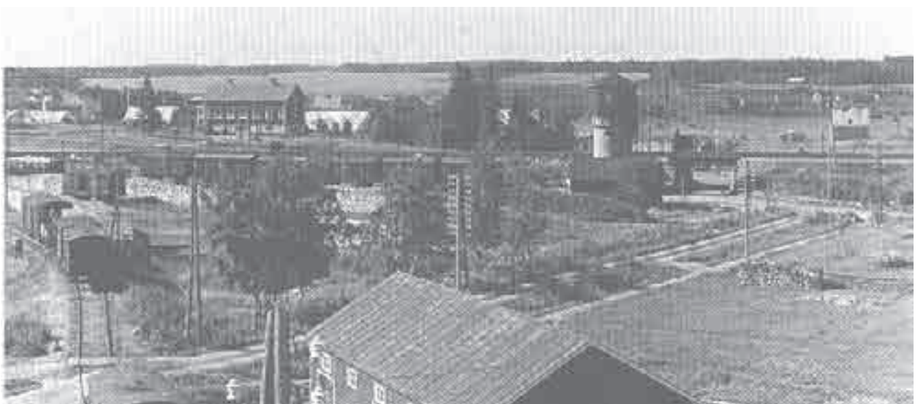
Radan pohjoispuolelta aseman suuntaan otettu kuva. Kuvan yläosassa vasemmalla näkyvä asemapäällikön asuinrakennus sijaitsi radan länsipuolella olevan kukkulan harjalla. Paikalla on nykyisin puisto. Taustalla näkyy peltotasanko ja Tuusulanjärvi. Järvenpää-seura/Rakennuskulttuurin ja kulttuurimaiseman tausta ja säilyminen Järvenpäässä.
