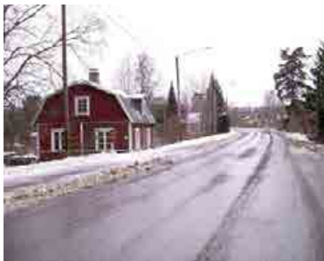
Vanhan valtatie tasauksen liiallinen nousu on uhka tien varren rakennuksille.
