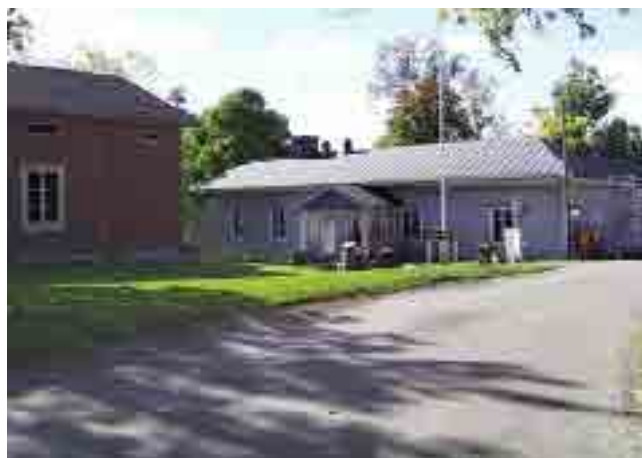
Vanhankylän kartanon päärakennus on rinteessä. Ylärinteen puolella sokkeli on erittäin matala. Tie on talon lattiaa korkeammalla. Tieltä valuvien vesien ohjaaminen on hoidettava, jotta rakennus säilyy kunnossa.
