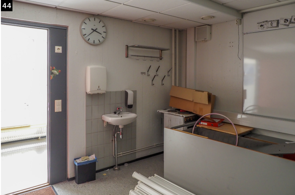
— Ensimmäisen kerroksen pienryhmälle tarkoitettu luokka on toteutettu 2004–2007 peruskorjauksessa. Luokan paikalla oli vielä 1980-luvulla tyttöjen ja poikien wc:t.
