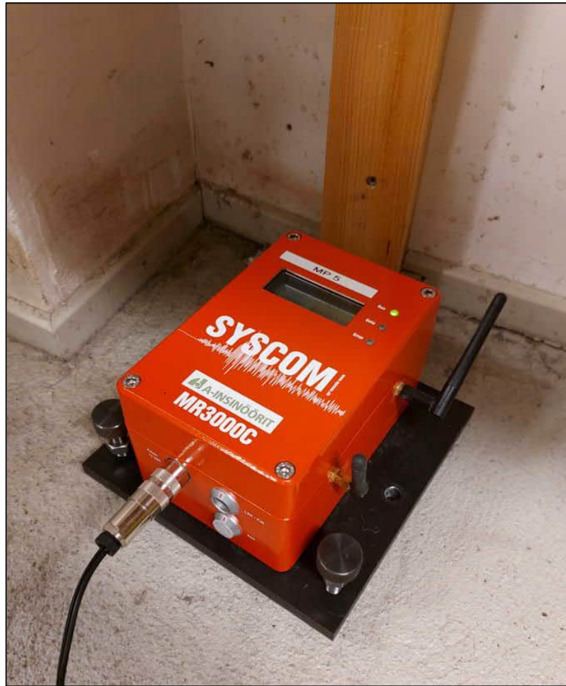
Kuva 5.2. Tärinämittarin asennus kellarin lattialle.
