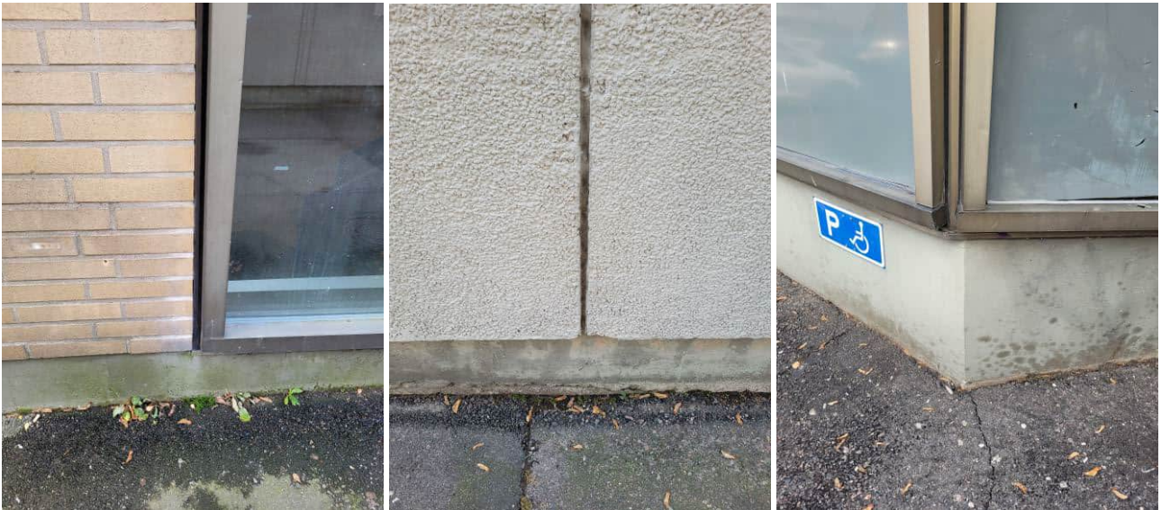
Kuva 37 Rakennusten sokkelien ja julkisivumateriaalien detaljeja.
