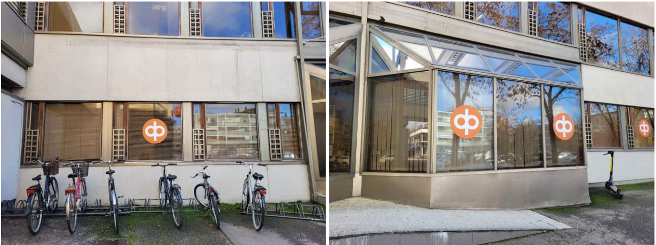
Kuva 35 Osuuspankin julkisivudetaljeissa on niin ikään alumiinisia detaljeja niin ikkunoiden putoamisesteissä kuin niiden puitteissa.
