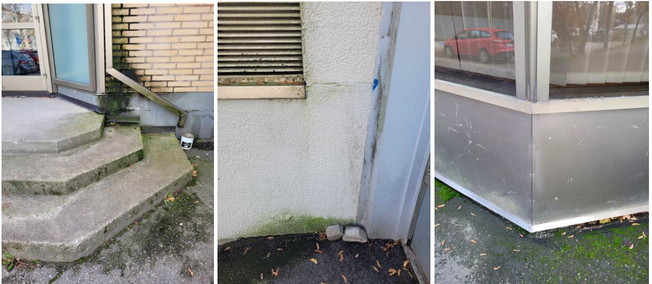
Kuva 36 Rakennuksien julkisivumateriaalien liittymisen yksityiskohtia.
