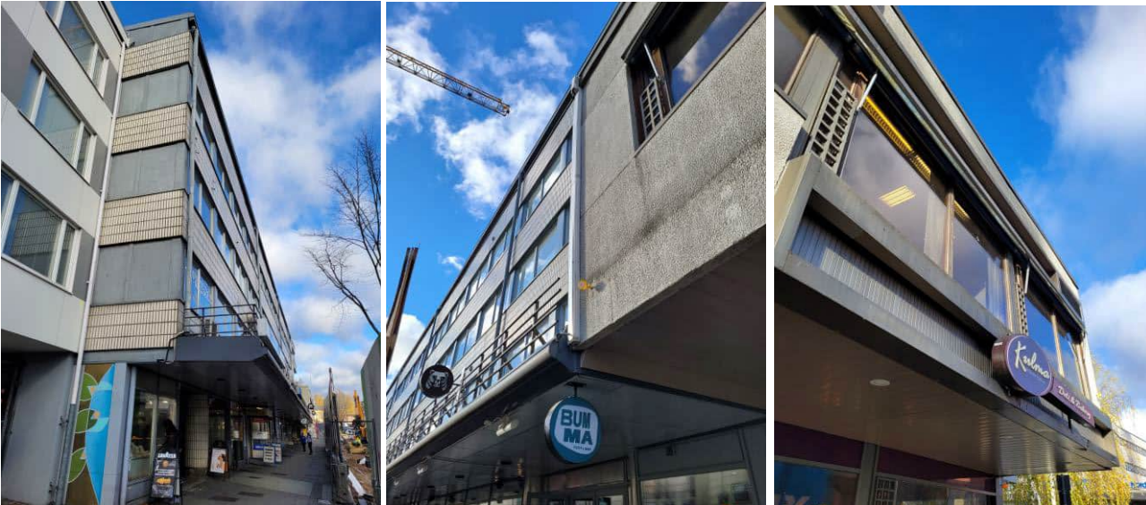
Kuva 40 Sibeliuksenkatu 19 ollut tien varressa alkuperäinen asuinkerrostalo, jonka linjaan myöhemmät rakennusvaiheet ovat liittyneet (vasemmalla). Sibeliuksenkatu 17:n ja 19:n julkisivut ovat samassa linjassa, mutta julkisivumateriaalit erottavat eri vuosien rakennukset toisestaan (keskellä). Osuuspankin talossa Sibeliuksenkadun ja Mannilantien risteyksessä on eniten julkisivudetaljeja (oikealla).
