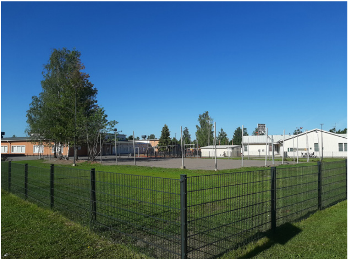
Nykyinen pallotila ja piha-alue Metsolantien ja MarSSIPolkun kulmasta katsottuna. Oikealla purettava päiväkoti ja vasemmalla koulumoduuli.
