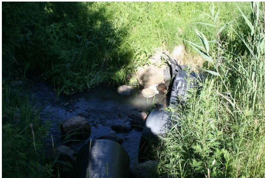
Kuva 133. Uomalaaksoon purkaa lukuisia isojakin hulevesiputkia.
