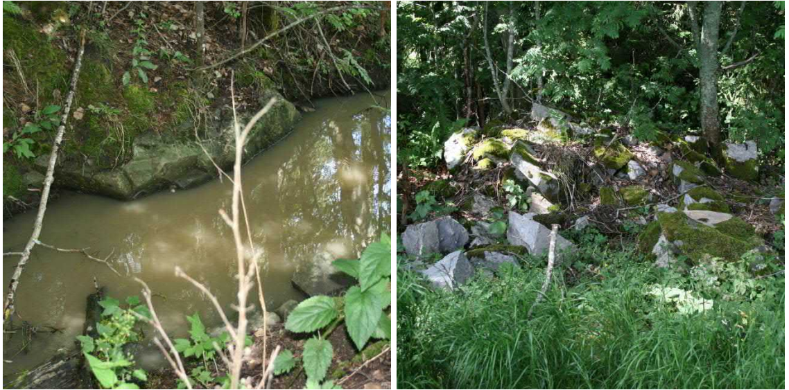
Kuva 6. Uoma on lohkottu oikaisemaan kallioisen metsän poikki ja kiviaines on läjitetty metsäalueelle.
