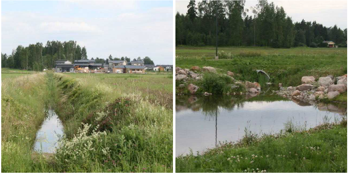
Kuva 77. Lepolan kosteikoista vedet puretaan Räikilänojaan noin 250 m Velitien jälkeen. Purku-uoma on kapea ja penkoiltaan voimakkaasti erodoitunut tuoden kiintoainesta Räikilänojaan.
