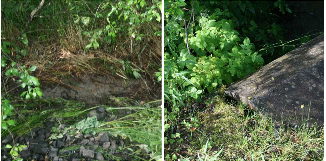
Kuva 13. Radan alta tulevan rummun viimeinen betoniekkelä on irti, virtaus on syövyttänyt vastapenkan ja uomaan on kertynyt kiviä.
