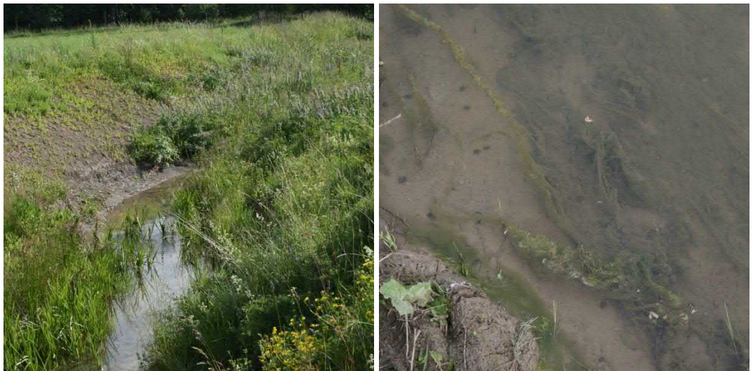
Kuva 83. a) Uoma on perattu ja luiskat tasakaltevat. b) Pohjassa on levää ja kotiloita.
