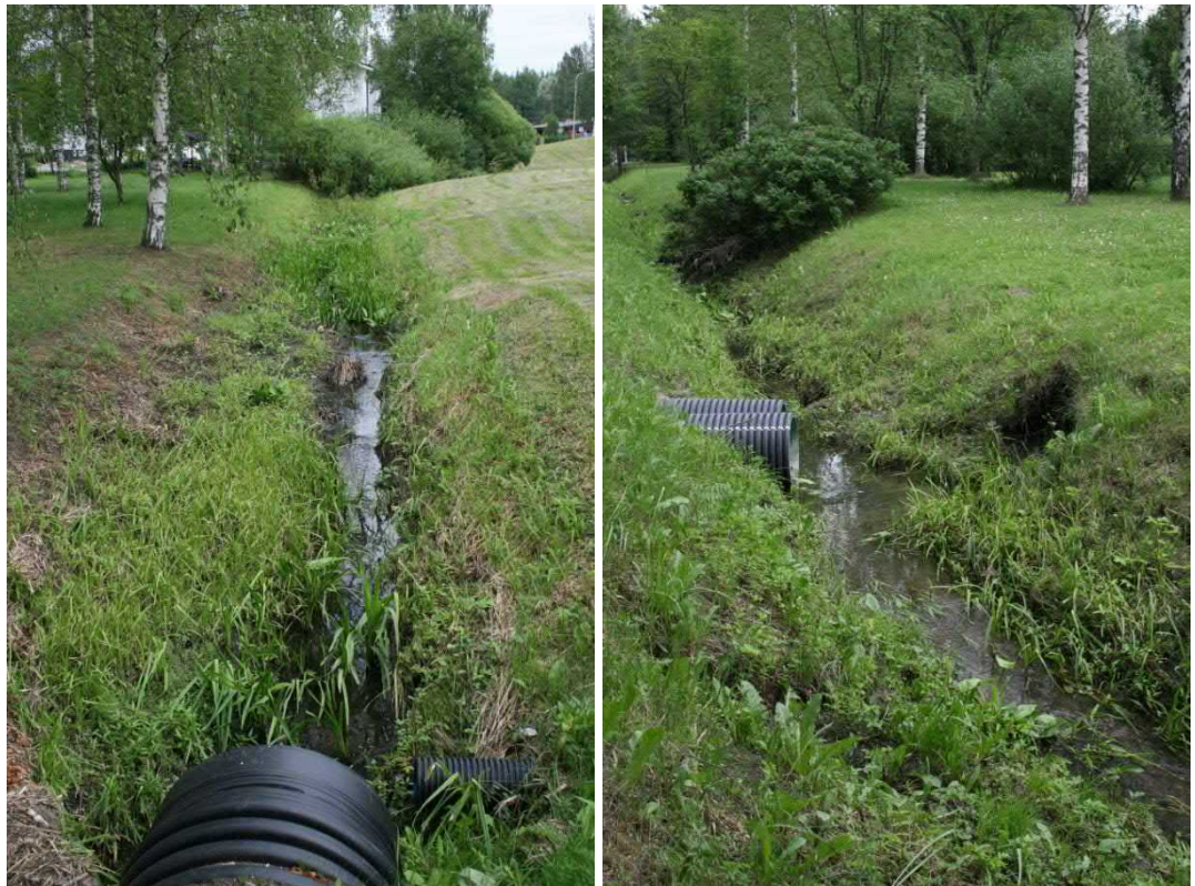
Kuva 71. a) Kulmakadun pohjoispuolisella puistoalueella ei uomalla ole monimuotoisuutta eikä luontoarvoja. b) Hulevesipurkputket ovat syövyttäneet ojan penkkaa huomattavasti.
