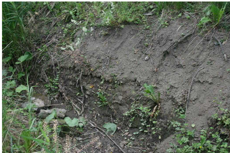
Kuva 29. Uomaeroosio on paikoin voimakasta.
