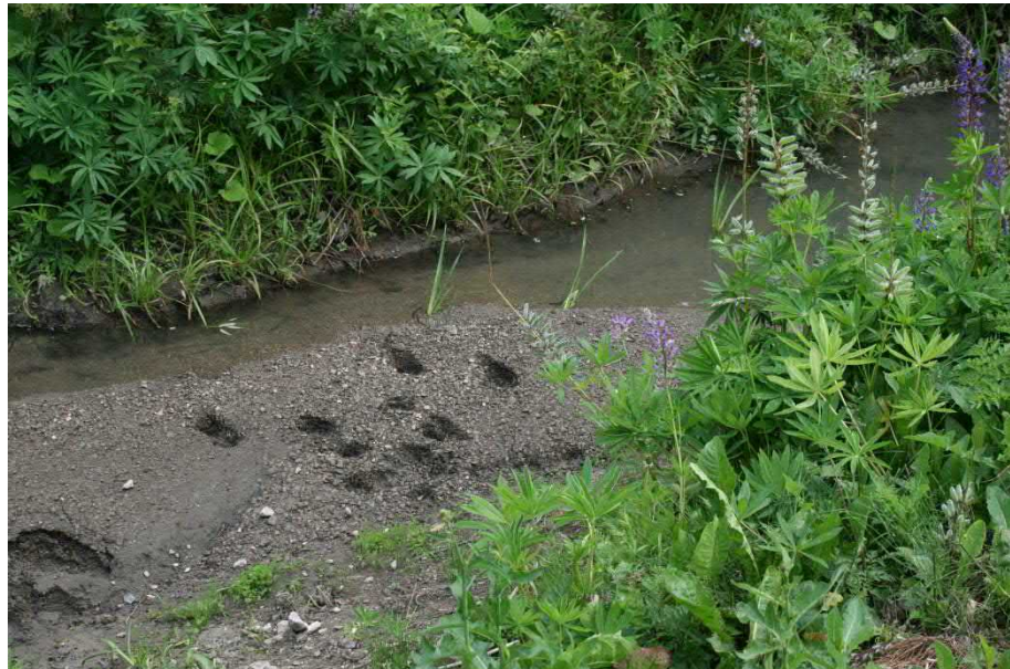
Kuva 91. Radanvarren ojaan on kertynyt huomattavasti kiintoainesta.
