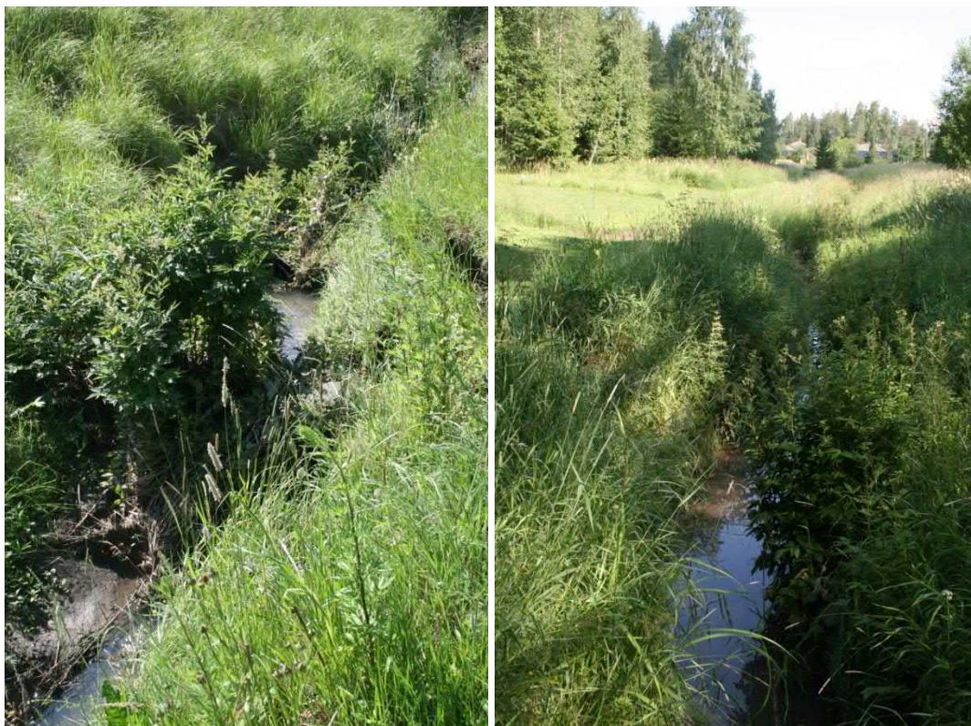
Kuva 99. Uoma on paikoin erodoitunut puistoalueella.
