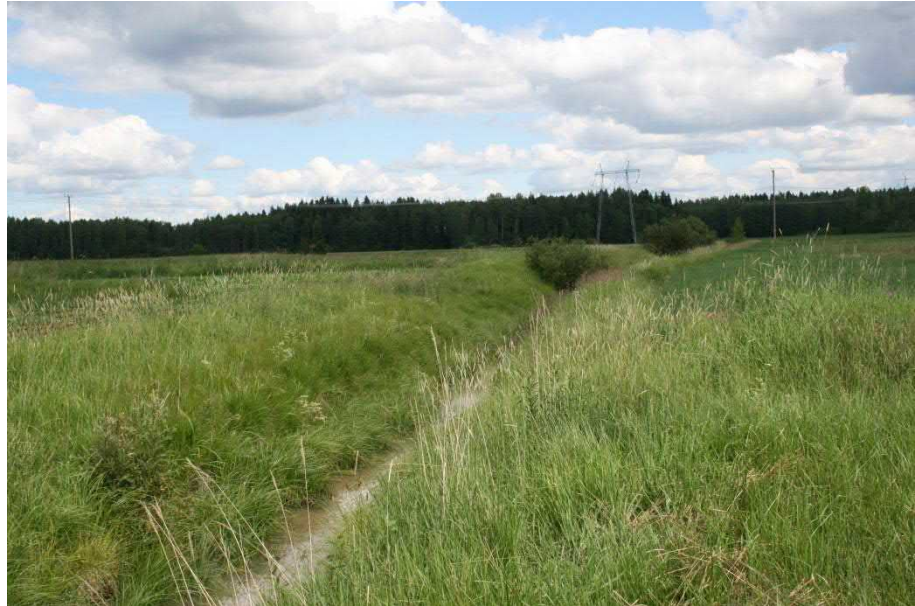
Kuva 4. Oja on perattu suoraksi ja leveäksi.
