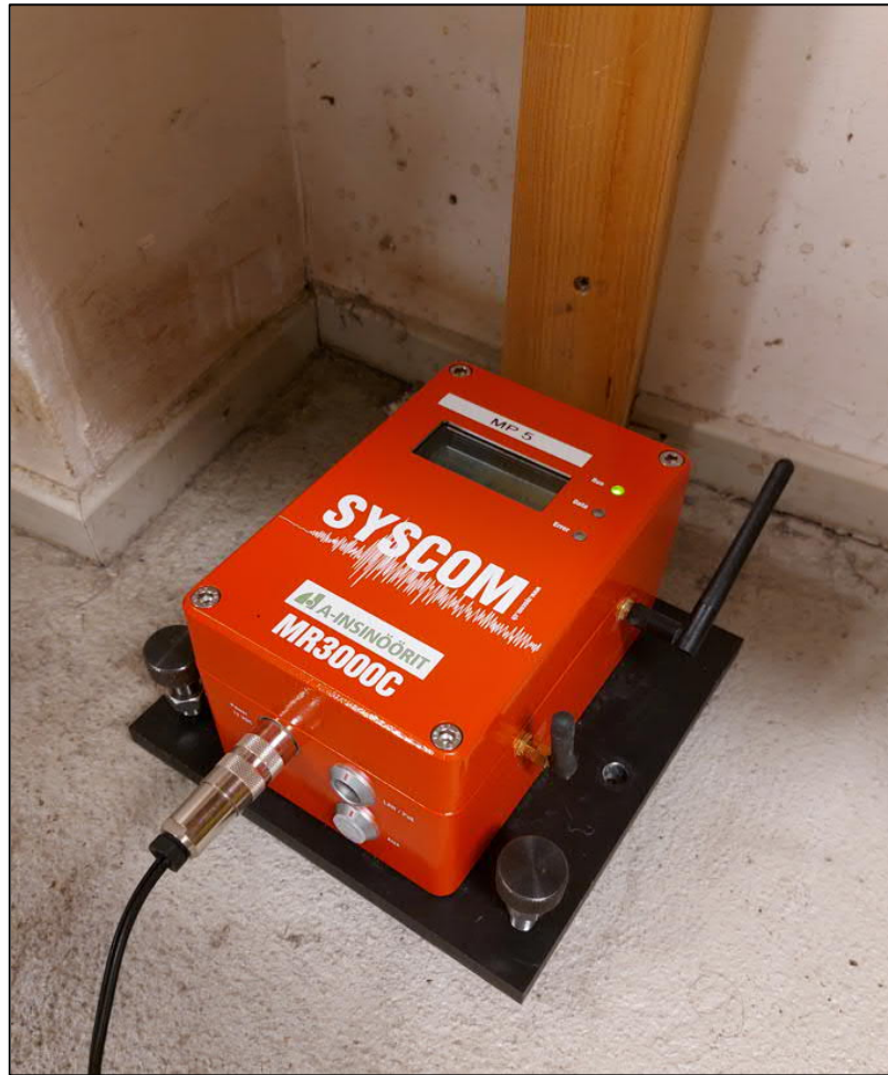
Kuva 5.2. Tärinämittarin asennus kellarin lattialle.
