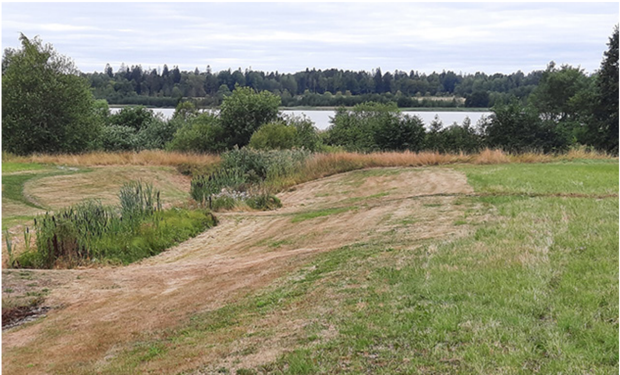
Näkymä Sipoontien länsipäästä järven yli, etualalla hulevesien viivytyrakenteita. Anni-tädin kylän rakennukset tulevat jonkin verran muuttamaan rantapuuston reunustamaa kaukomaisemaa länsirannalla.
