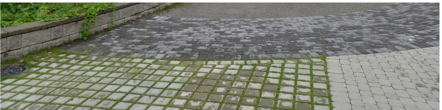
Kuva 6. Pinnoitteissa kannattaa suosia läpäiseviä tai puoliläpäiseviä pintoja, kuten nurmisaumaiset kiveykset ja kivituhka.
